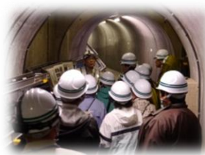
〈堤体内監査廊見学〉
