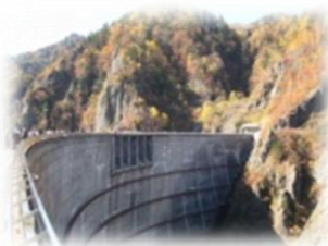
〈ダム堤体全景〉
