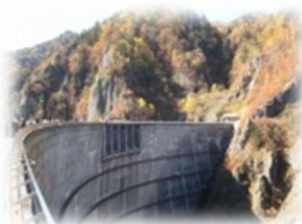
〈ダム堤体全景〉
