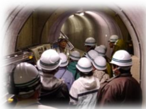
〈堤体内監査廊見学〉
