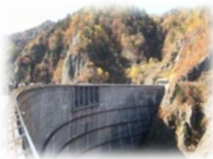
〈ダム堤体全景〉
