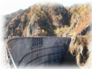
〈ダム堤体全景〉
