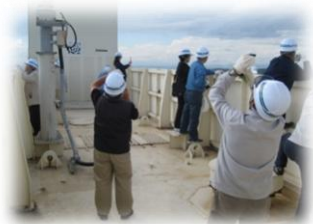
〈主塔中間部の見学〉
