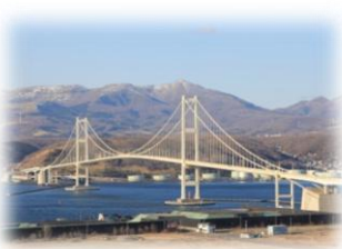
〈白鳥大橋全景〉
