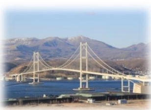
〈白鳥大橋全景〉
