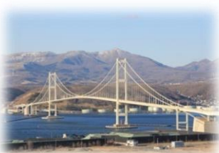
〈白鳥大橋全景〉
