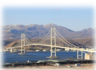
〈白鳥大橋全景〉
