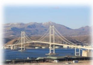
〈白鳥大橋全景〉
