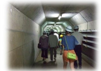
〈滝里ダム監査廊見学〉
