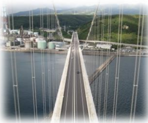
〈白鳥大橋主塔から〉
