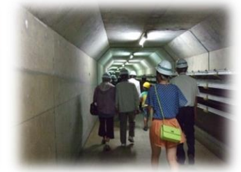
〈滝里ダム監査廊見学〉
