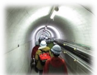
滝里ダム(監査廊)
