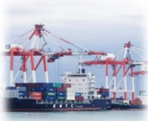
苫小牧港(東港区)
