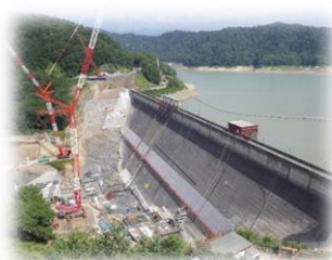
新桂沢ダム(嵩上工事)
