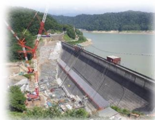
新桂沢ダム(嵩上工事)
