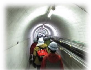
滝里ダム(監査廊)
