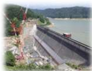
新桂沢ダム (嵩上工事)
