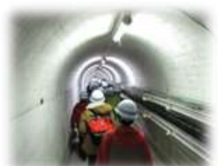
滝里ダム (監査廊)
