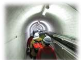
滝里ダム (監査廊)
