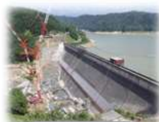
新桂沢ダム (嵩上工事)
